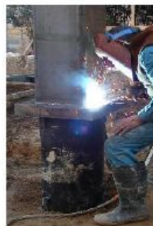
下向き溶接のみにて施工
