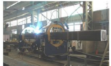
WAWO構法によって実現する鉄骨の自動溶接
